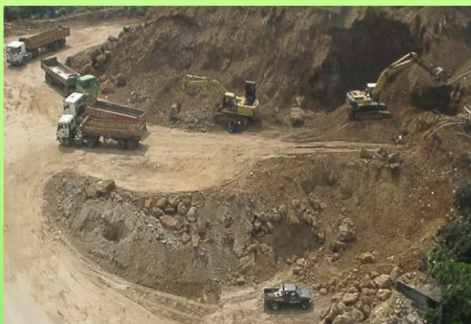
土方移除以機械開挖
