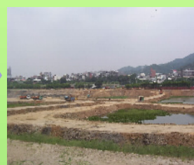
行水區便道圍堰
