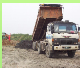
配合旗幟倒土
