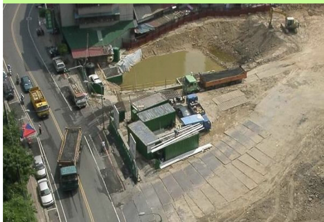
工區內工務所、洗車台、沉砂池、 臨時廁所及車輛運送情況
