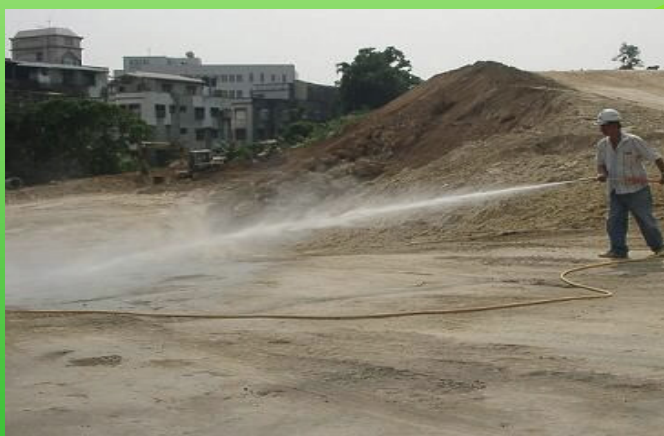
裸露面地表適度洒水
