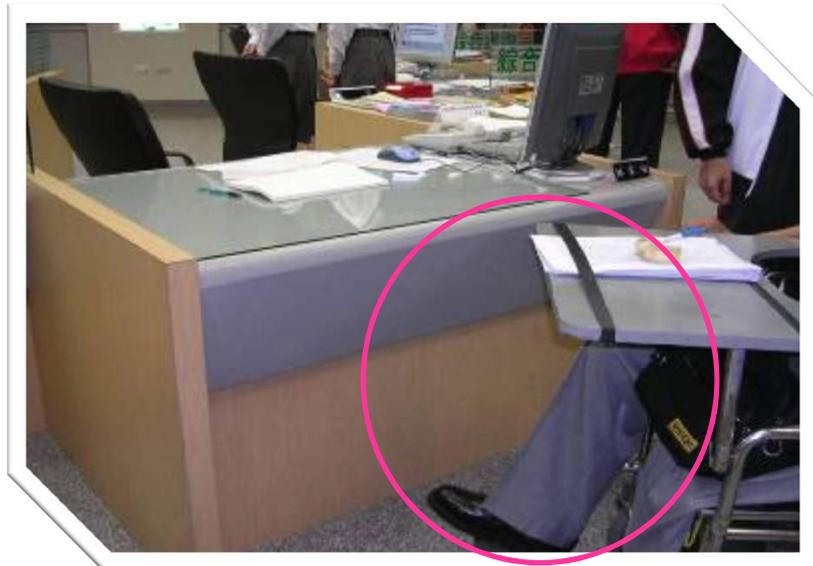
圖23 未考量輪椅與工作面間所需尺寸之洗手台、櫃台與工作台
