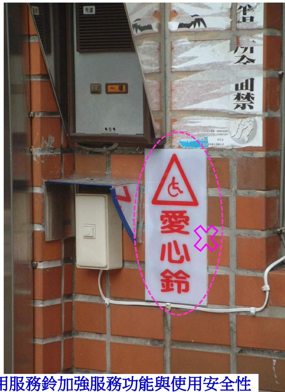
圖58 過大坡度之坡道利用服務鈴加強服務功能與使用安全性
