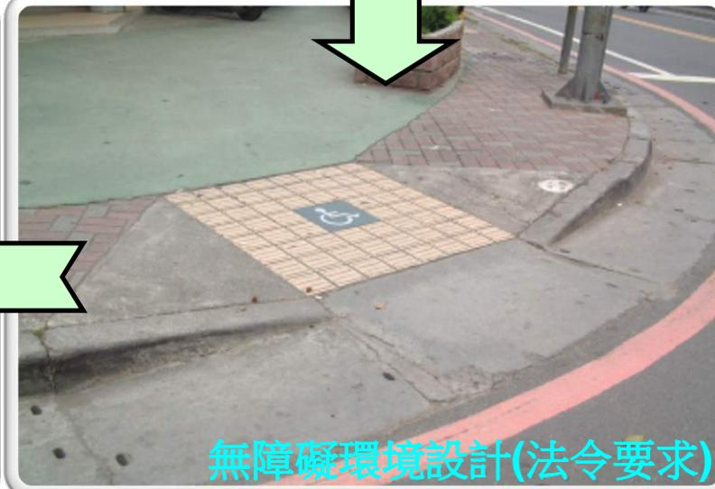
圖3 障礙環境、無障礙設計以及通用設計的差異〈以路緣斜坡為例〉
