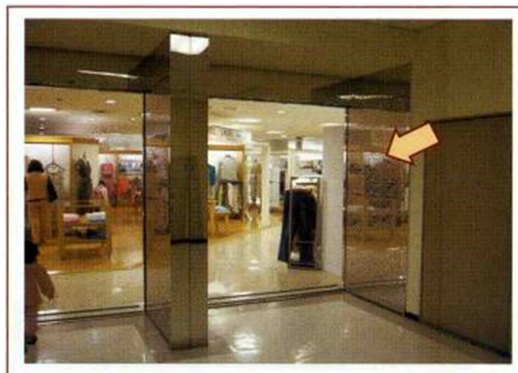
▲ 常時開放式防火門案例，該類門扇應 與消防設備火警警報系統連動。
