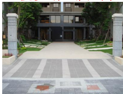
改善後照片, 已清除鐵門
