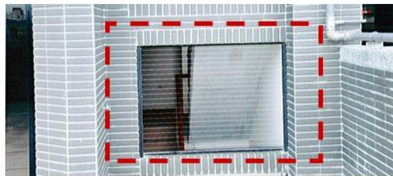
戶外安全梯開口-安全防護措施改善，設置隱形鐵窗
