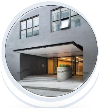
避難層坡道及扶手
