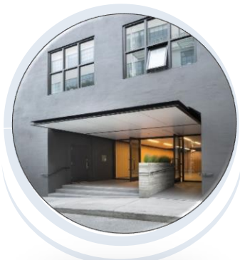
避難層坡道及扶手
