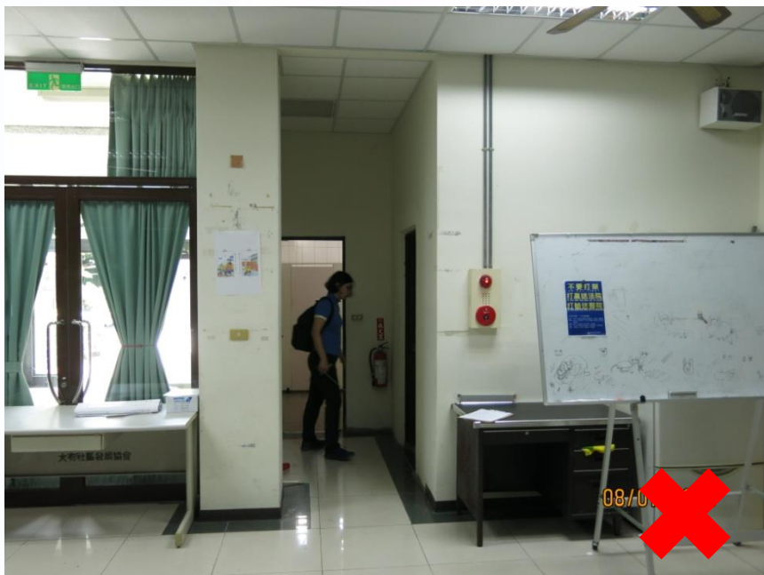
■室內通路及迴轉空間不足
