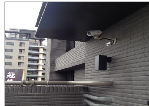
圖23 加裝監視設備
