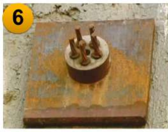
6 地錨擋土牆錨座掉落、分離、鏽蝕
