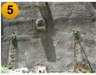
5 擋土牆一半以上洶水孔阻塞或洶出含泥砂水
