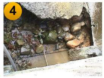
4 擋土牆牆趾洶空外露
