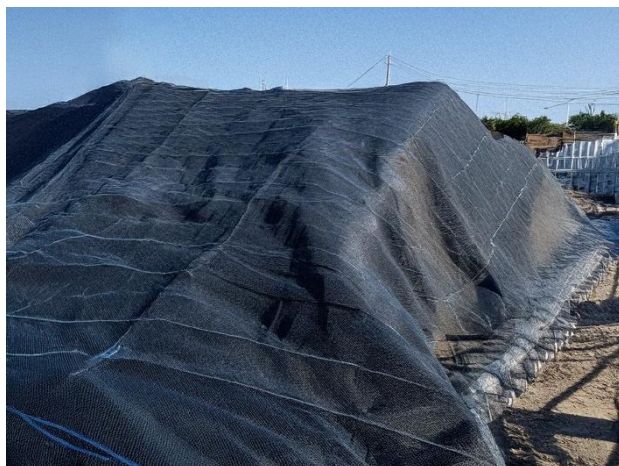
2. 暫置區土堆防塵網設置
