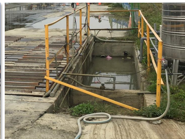
8. 簡易工地沉砂池設置
