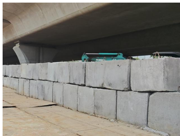
6. 實體混凝土塊分區阻隔、防塵隔音
