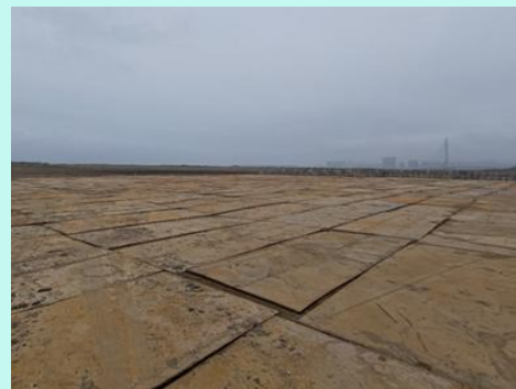
鋪設鋼板暫置餘土
