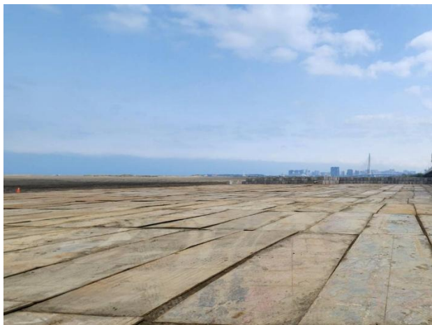
1. 地面設置鋼板，防止揚塵
