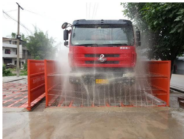
3. 非固定式洗車台設置
