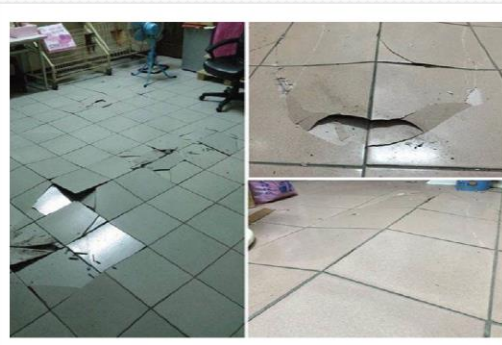
磁磚鼓起破裂
