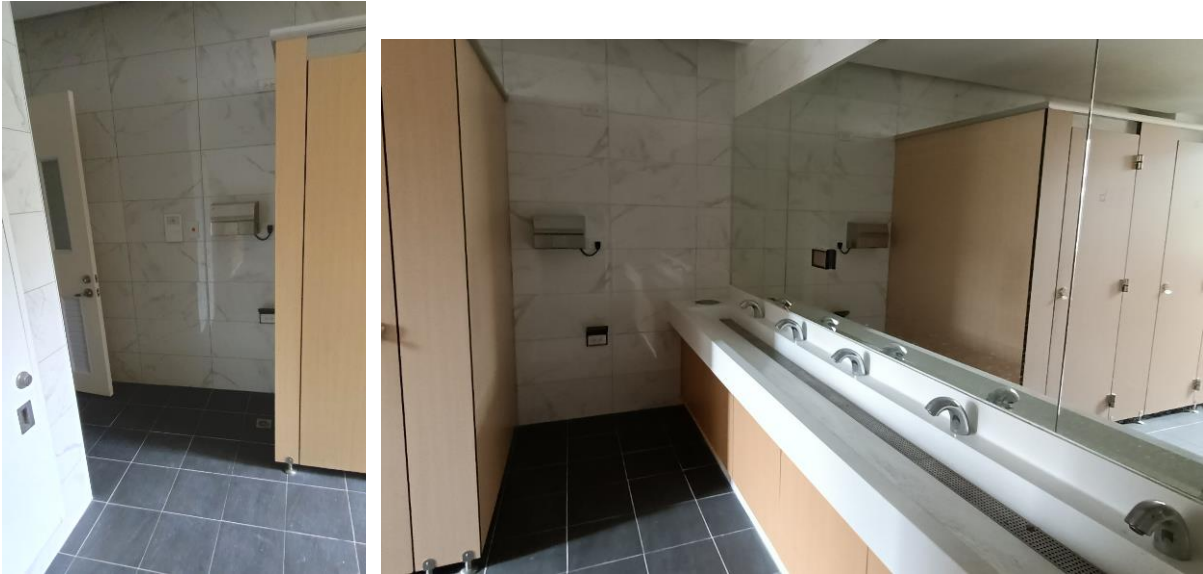
圖五 入口處輪椅迴轉空間不足、洗手台下方封閉對輪椅者不友善
