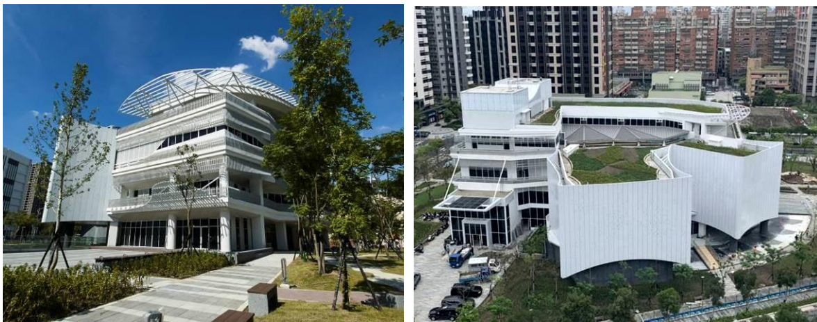
圖一 國家電影中心建築物外觀
